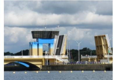
Long d'environ 500 m, le barrage est constitué d'une digue (côté Camoël) et de cinq portes. Pour le sein, il a fallu manier le béton à la tonne. Il est doté d'une écluse qui permet la navigation entre le fleuve et l'océan. Il est aussi mis à profit pour assurer l'approvisionnement en eau potable, soit une réserve d'eau douce de 50 millions de m<sup>3</sup>, ce n'est pas la mer à boire ! En été visitez la passe à poissons aménagée en 1995.
